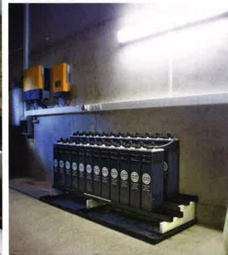
Die Photovoltaikanlage erzeugt bei Sonnenschein mehr Strom als verbraucht wird. Die überschüssige Energie speichern 24 Hochleistungsbatterien.
