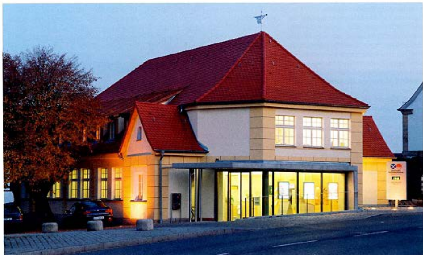
Der ehemalige Tanzsaal wurde komplett umgebaut und behutsam modernisiert.
