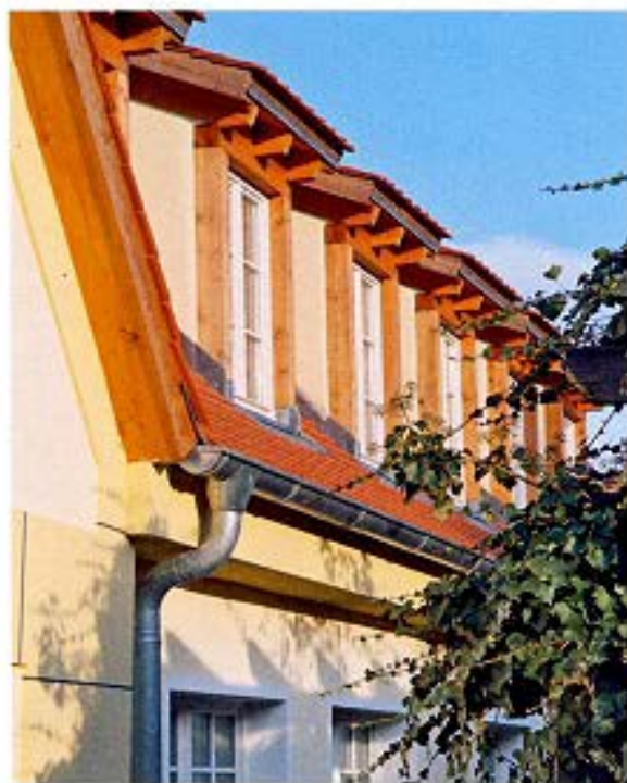
Um auch ins neue OG Licht zu bringen, hat der Architekt kleine Gauben ins Dach gesetzt.
