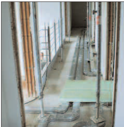
Bild 7: Unter dem Estrich verbinden Bodenkanäle die einzelnen Räume
