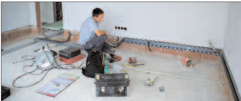
Bild 6: In jedem Raum befindet sich an der Wand ein Sockelkanal. Dieser nimmt die Verkabelung für Netzversorgung sowie der Gebäudeverkabelung auf
