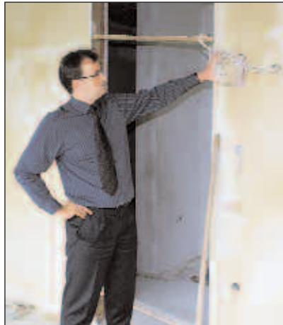
Bild 3: H. Neudörfer zeigt auf einen Auslass für das Sonderkabel: In Augenhöhe befindet sich an jedem Raumeingang später ein Touchscreen für die Gebäudesteuerung
