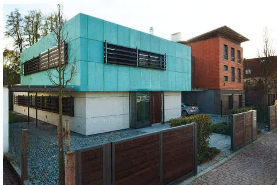
Das Haus sticht mit seiner markanten Fassade heraus: Das zu Straße hin auskragende Obergeschoss ist mit einem vorpatinierten Kupferblech verkleidet
